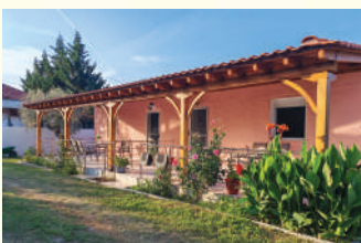
11. KUĆA MARIA GPS N39.97996/E23.90863
