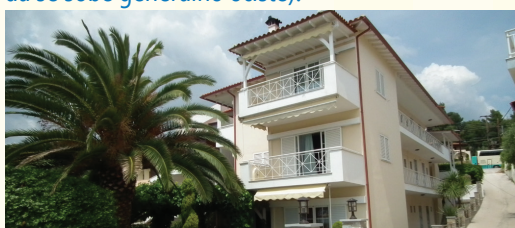
KUĆA PORTO PSAKOUDIA GPS N40.25943/E23.48847
