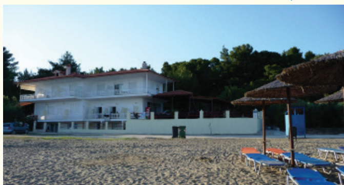
KUĆA ALEXANDRA GPS N 40.259388/E 23.490658
